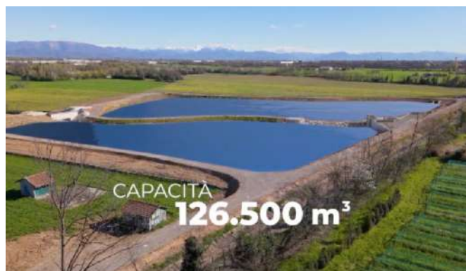
Vasche di laminazione di Gessate conclusa nel 2025 (Sx) e Inzago (dx) durante l’evento di piena del 15 maggio 2025 (quella di Gessate è stata completata nel 2025 ma durante il 2024 laminò comunque volumi idraulici) – fonte Consorzio Ticino Est Villoresi
